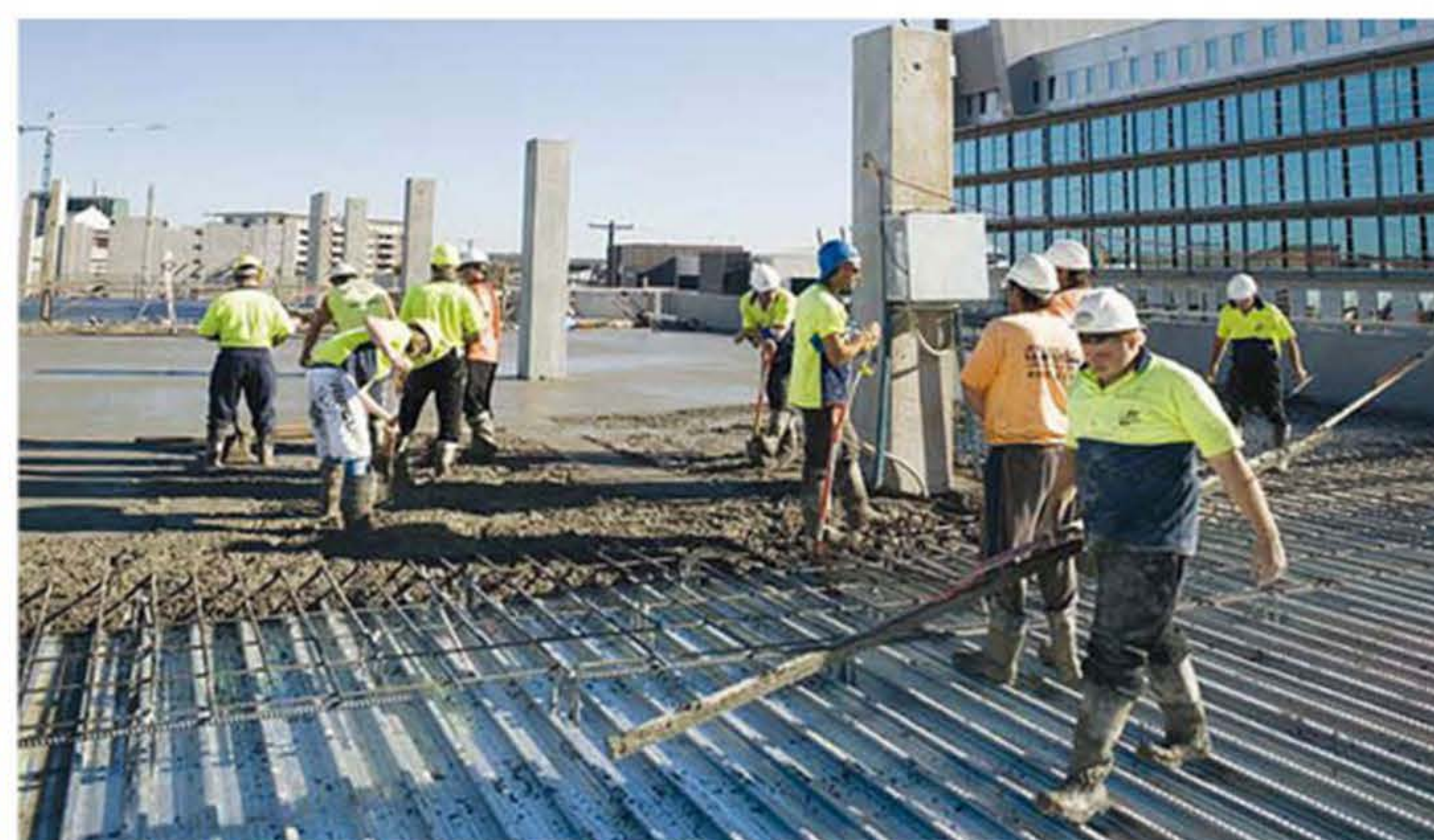
การเทคอนกรีต
