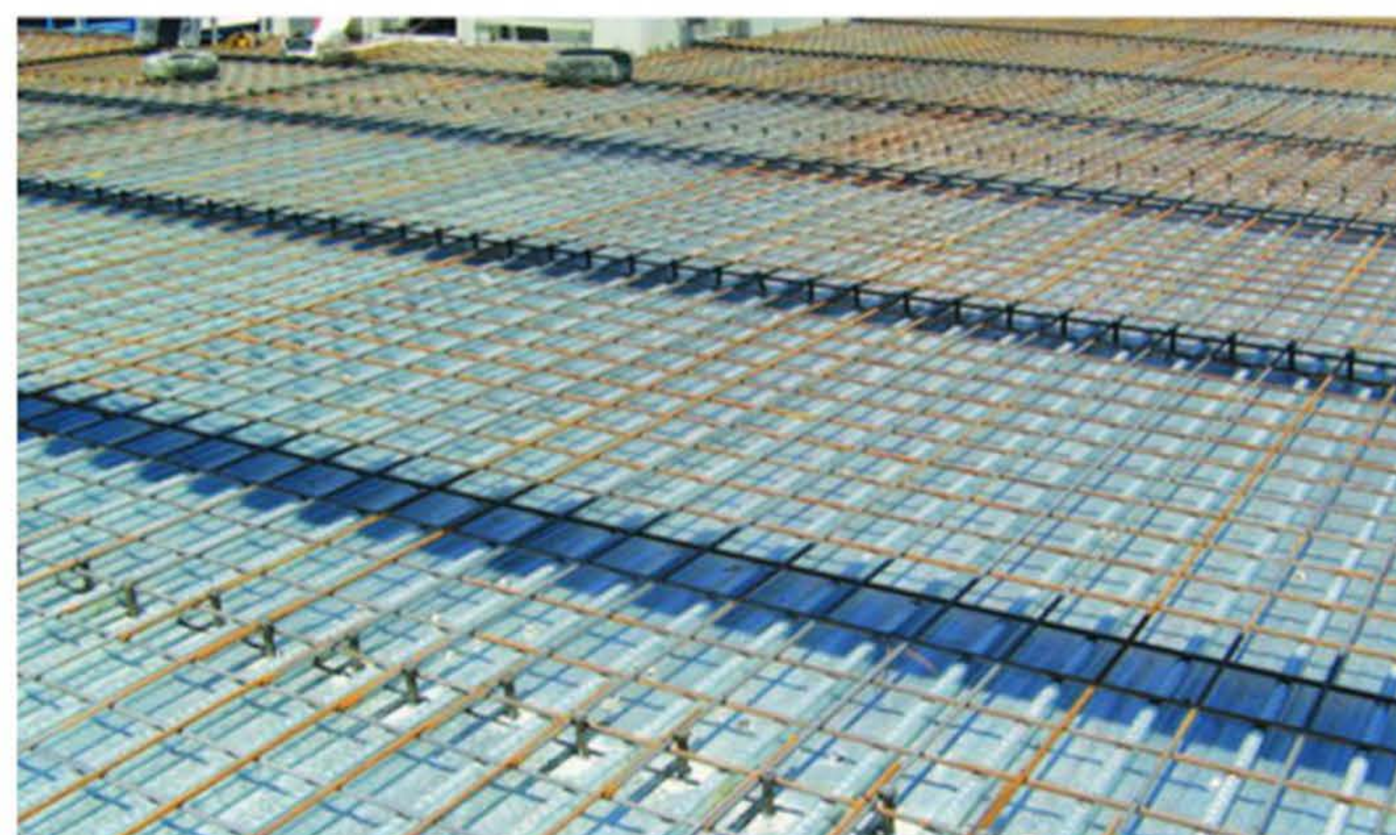
เสริมเหล็กกับแรงดึง(เหล็กบน)และเหล็กเสริมกันร้าว
