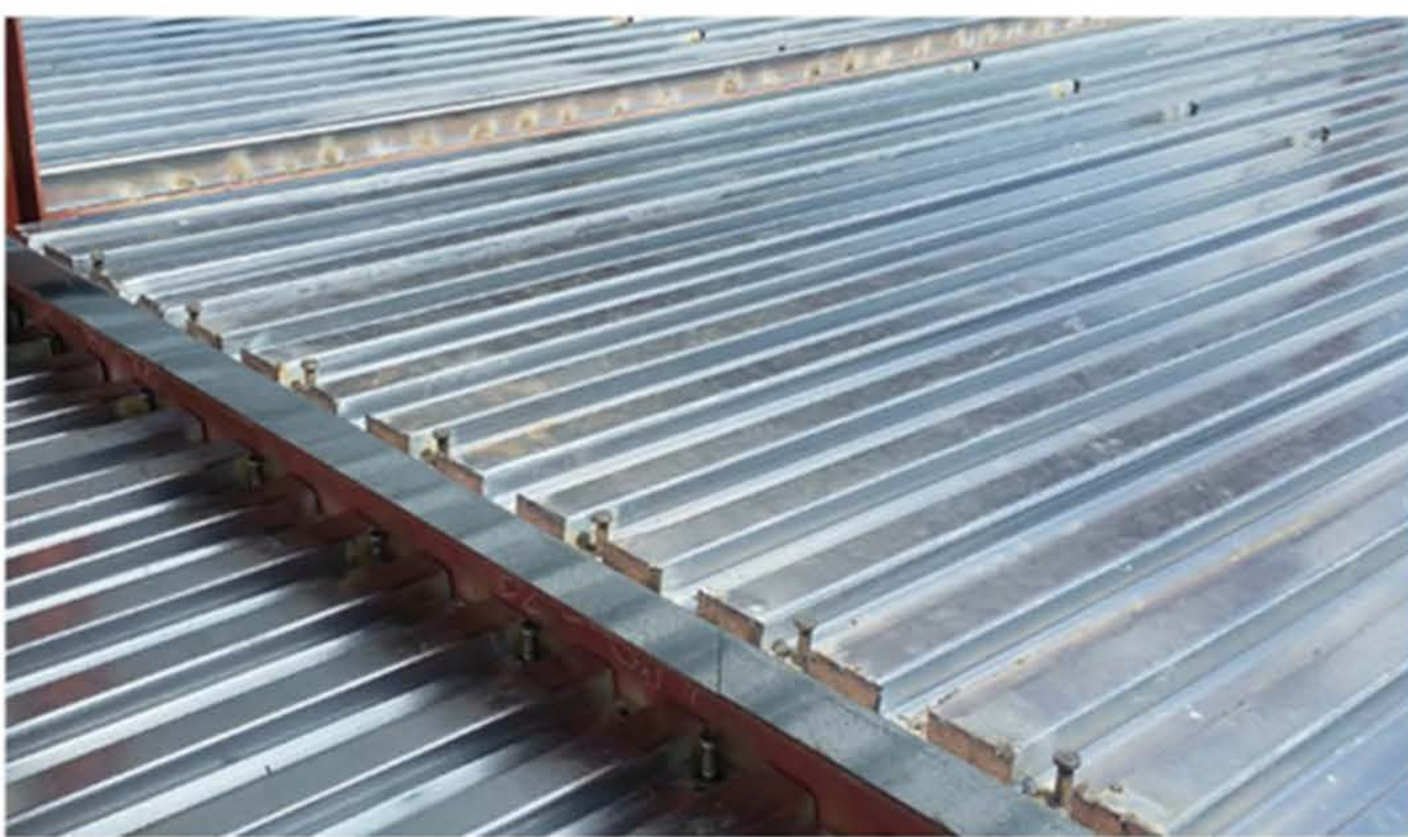
ใส่ Accessories เช่น Edge Form,Closer,Profile End Closer
