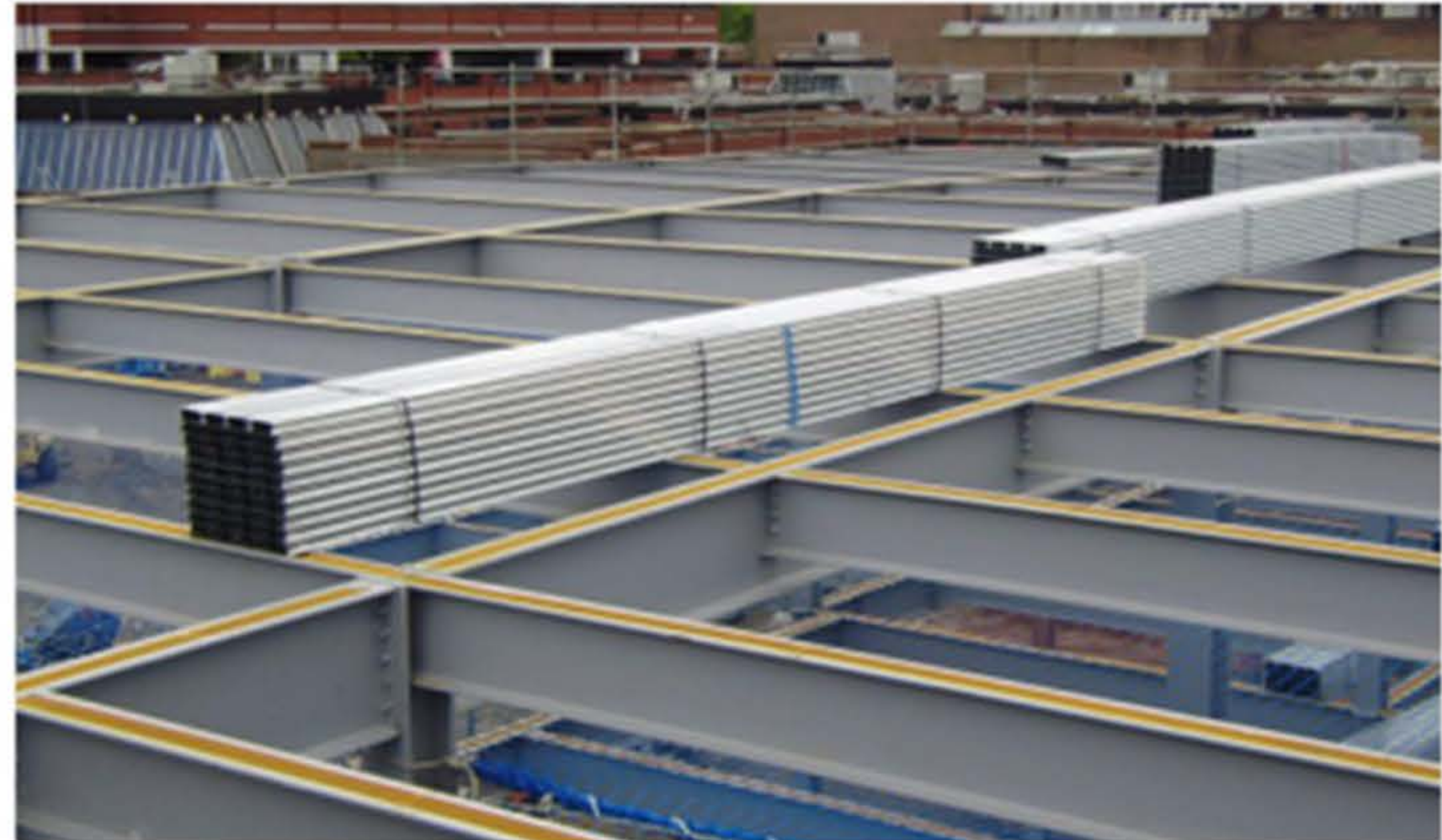
กองแผ่น Metal deck บนโครงสร้างและคานเหล็กเพื่อเตรียมติดตั้ง (สามารถใช้แผ่น Deck กับคานคอนกรีตได้)
