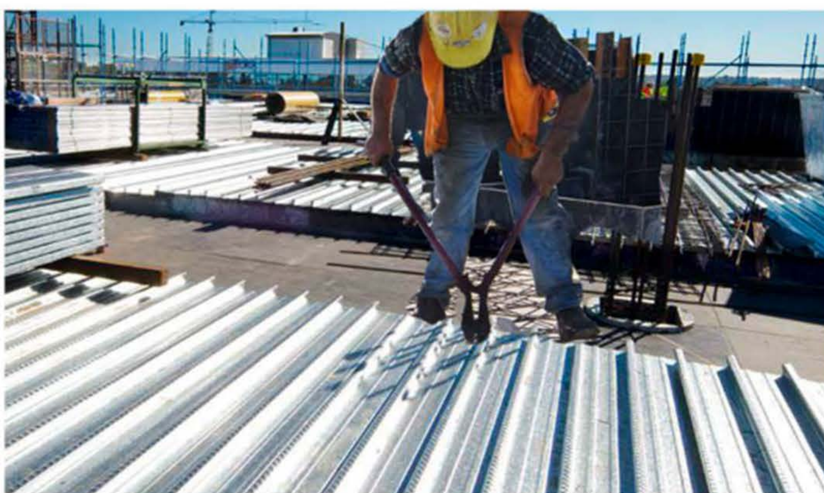
หนีบด้วย Punching Tool บริเวณรอยต่อของแผ่น
