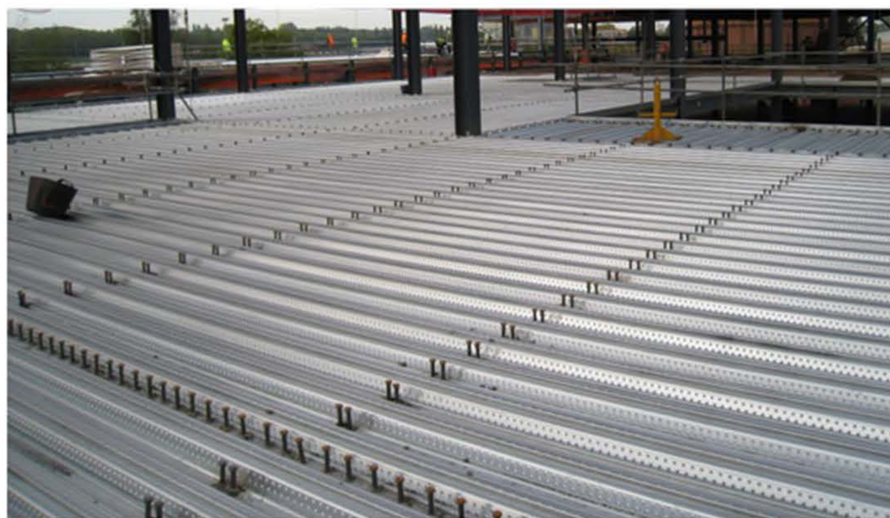
ติดตั้ง Shear Stud จนครบ
